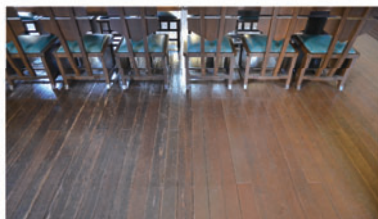
保存修理時にまだ使える床材を集めて、オリジナルの床を再現(左側の色の濃い部分)
