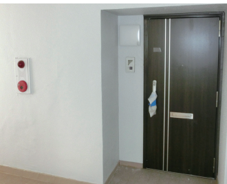
震災後、壁やドアが修復された被災マンション。柱や梁などの構造体が壊れなかったので、修復できた。(写真提供・長谷工リフォーム)
